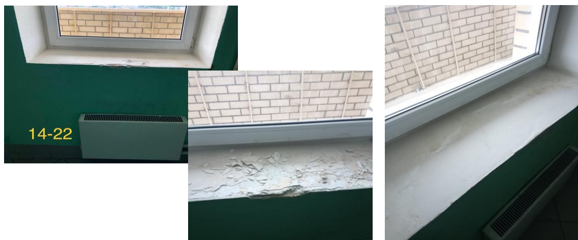
5) 30.11.23 Этаж 22 - Ремонт разрушенного подоконника
